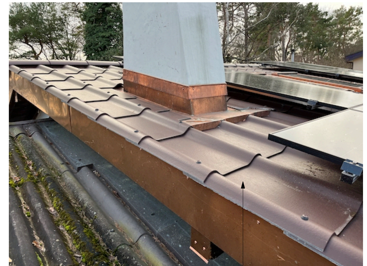
revêtement de toiture en éléments ondulés identiques à la toiture existante, secteur ouest
